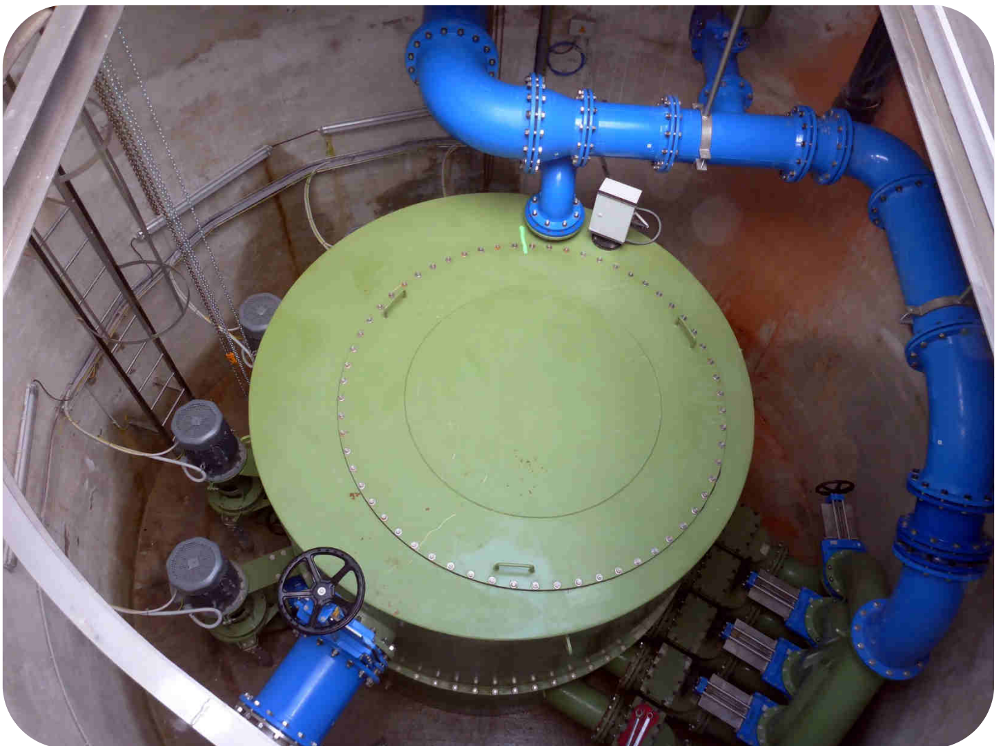
Obrázok 4 Osadenie technológie čerpacej stanice
