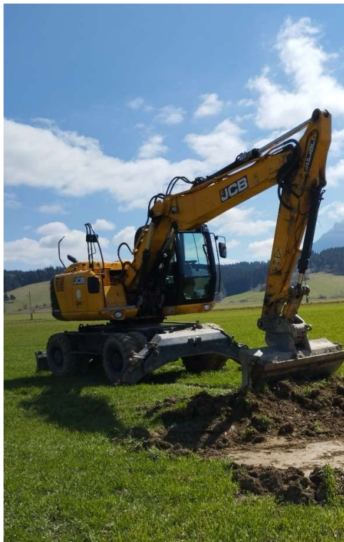
Obr. 5: Sťahovanie ornice a výkopové práce pre uloženie výtlačného potrubia „V1“ - PE-HD DN200 (SS.07)
