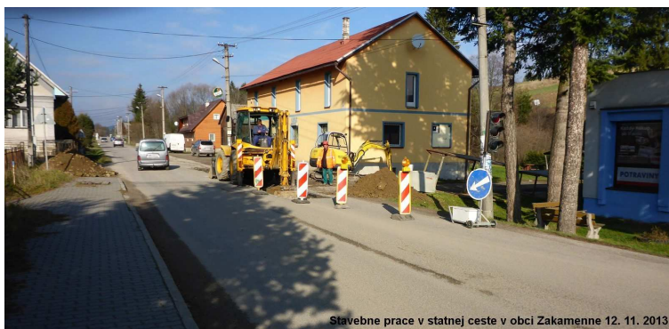
Stavebné práce v statnej ceste v obci Zakamenne 12. 11. 2013
